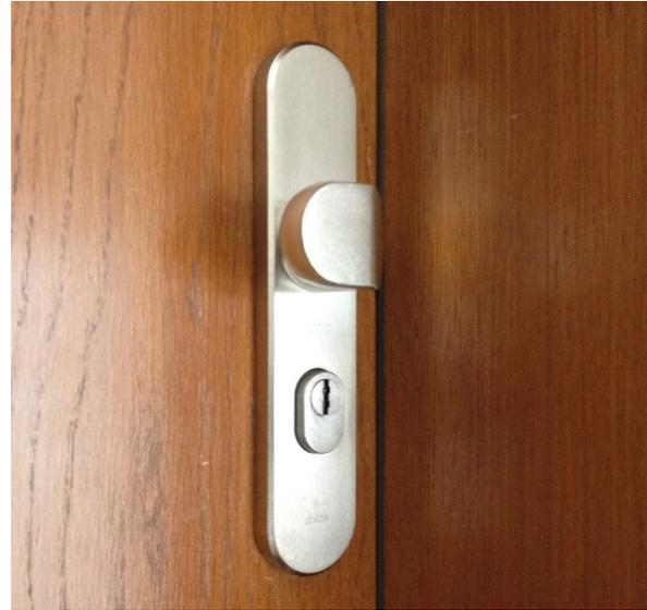
**Bild 6-5:** Türschild mit Kernziehschutz-Rosette
