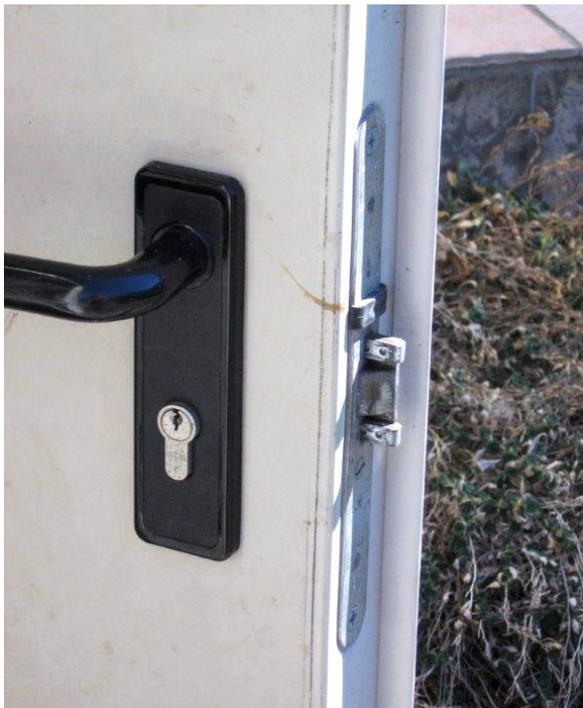
**Bild 6-8:** Notausgangsschloss, schwache Ausführung
