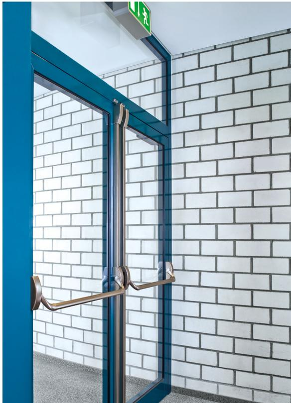
**Bild 6-11:** Druckbügel eines Panikverschlusses
